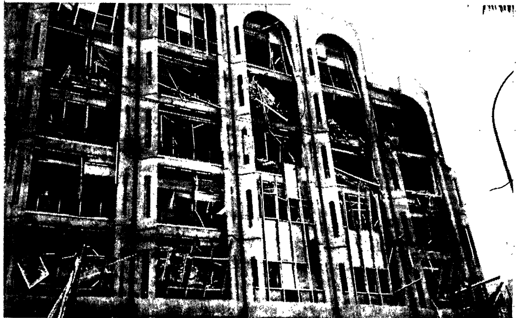
Les effets de la guerre chirurgicale : les immeubles sont détruits de l'intérieur
