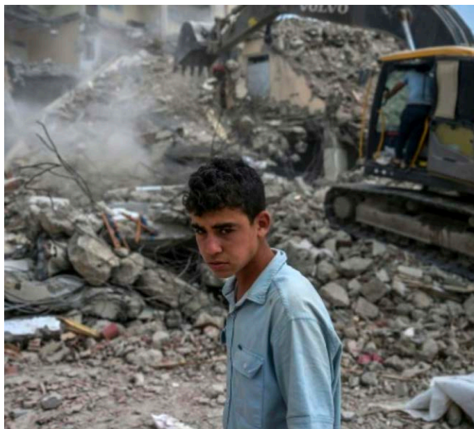
Les mâchoires de la pelleteuse attaquent la structure béante de l'immeuble pour en arracher les derniers pans encore debout qui s'écrasent dans un nuage de poussière.
