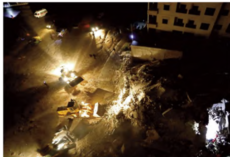
Les secours recherchent des victimes dans les décombres d'immeubles ciblés par l'aviation syrienne, à Idlib, le 4 février 2018.
