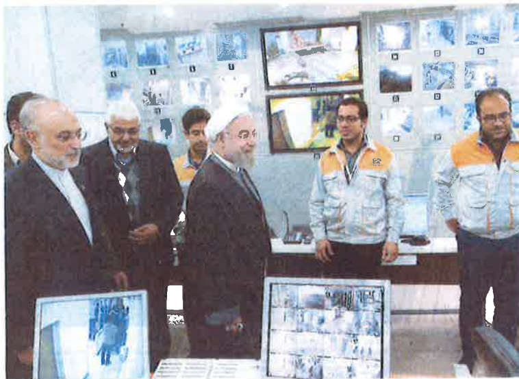
Le président Hassan Rohani (au centre) dans la salle de contrôle de la centrale nucléaire de Bouchehr, le 13 janvier. MOHAMMAD BERNO/AFP
