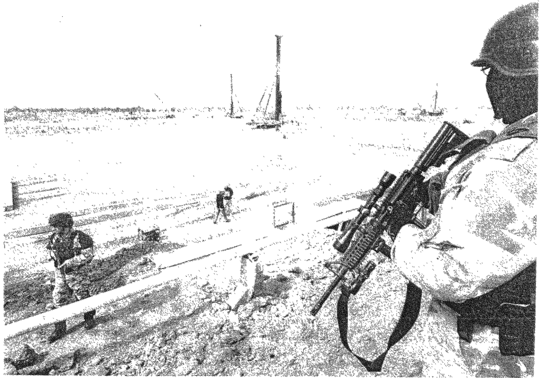
Le site de la future station de traitement des eaux du groupe français Suez Environnement, à Rusafa, dans le nord de Bagdad. CHAMUSSY/SIPA
