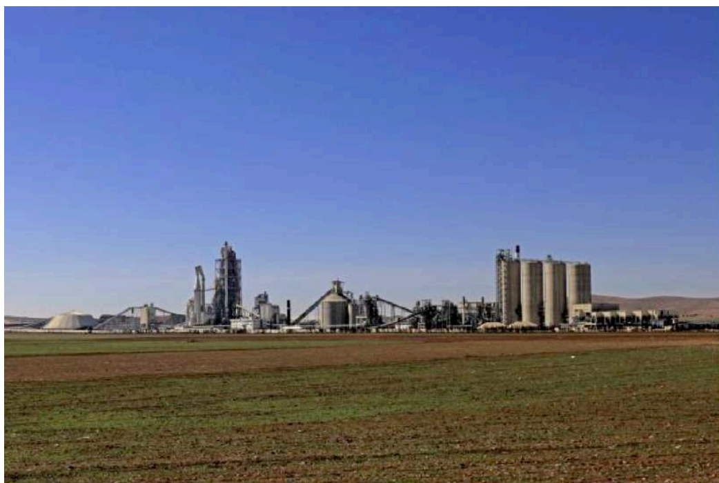
La cimenterie de Lafarge à Jalabiya, dans le nord de la Syrie, le 19 février 2018. DELIL SOULEIMAN / AFP
