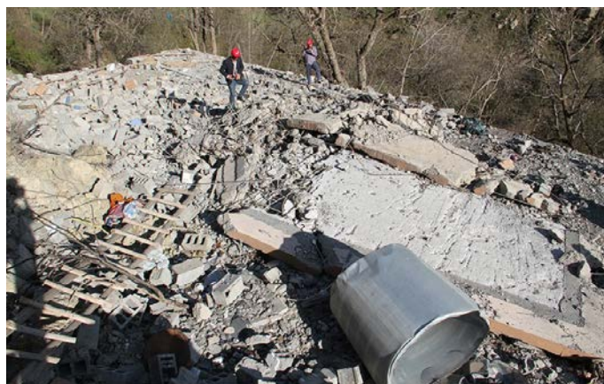
Ruines d'une maison bombardée dans le village de Sarkan
